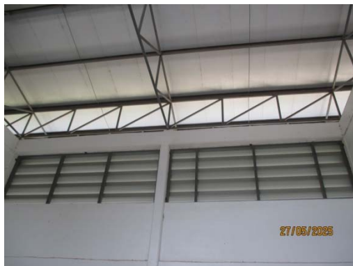
รูปที่ 3-53 ช่องระบายอากาศของอาคารเก็บสารเคมี
