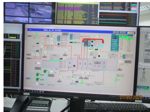
รูปที่ 3-2 หน้าจอ DCS แสดงระบบเตือน (Alarm) ควบคุมค่าการระบาย \text{NO}_x
