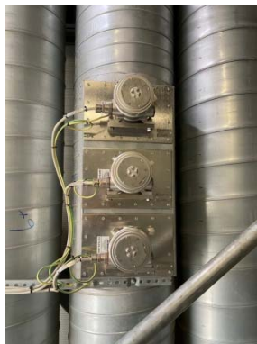
รูปที่ 3-43 ระบบตรวจจับก๊าซ (Gas Detector)
