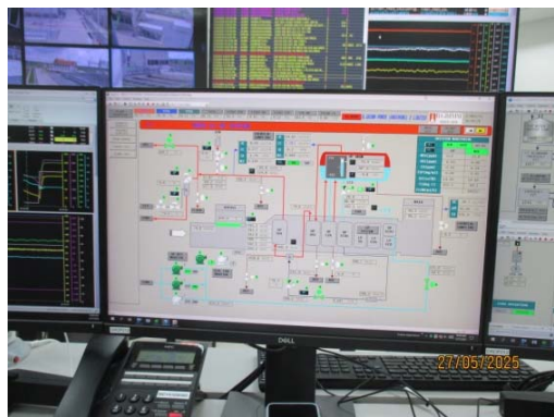
รูปที่ 3-2 หน้าจอ DCS แสดงระบบเตือน (Alarm) ควบคุมค่าการระบาย \text{NO}_x
