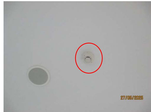
รูปที่ 3-59 อุปกรณ์ตรวจจับควัน (Smoke Detector)
