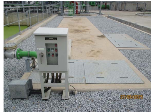
รูปที่ 3-33 ป่อแยกน้ำมัน (Oil Separator)
