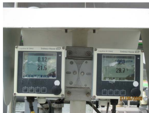
รูปที่ 3-28 ระบบตรวจสอบคุณภาพน้ำแบบต่อเนื่อง (Online Monitoring) ที่บ่อกักน้ำทิ้งจากหอหล่อเย็น (CT Blow Down Pit)
